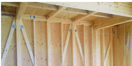
一般的な 「木造軸組工法」
